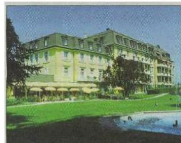
Die Renovation des Park-Hotels am Rhein ist im Herbst fertig.
