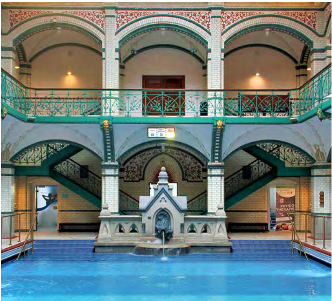
Das Mehrzweckbecken im Zwickauer Johannisbad hat einen variablen Hubboden.
