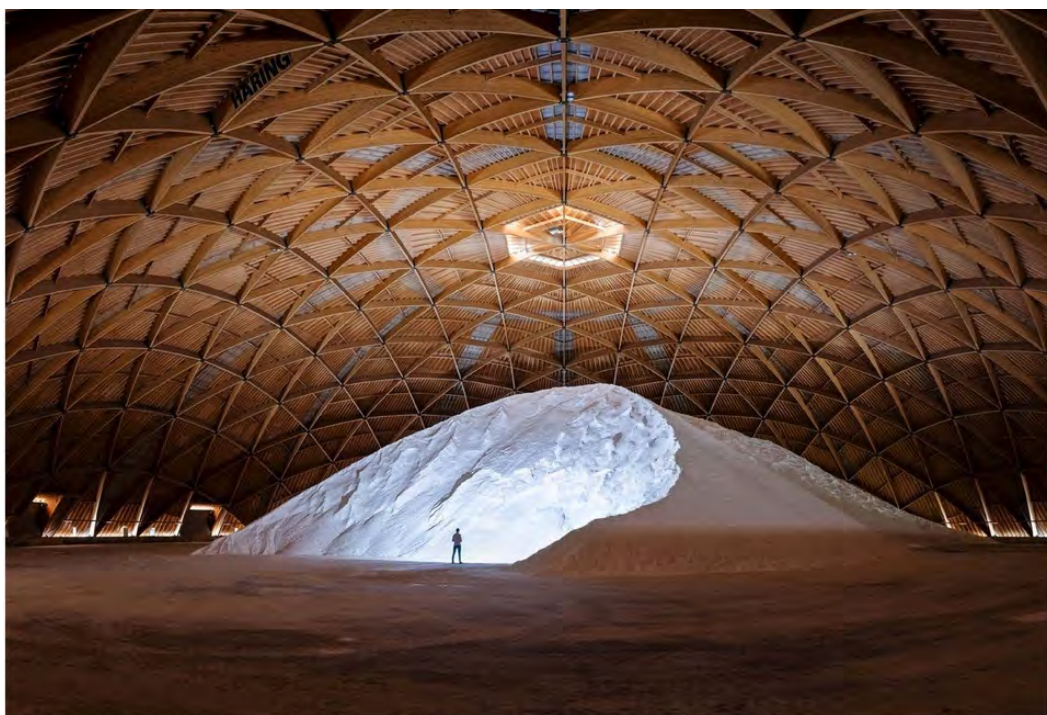
Auch in der Saline Riburg lernt man viel über das «Weisse Gold». Die Salzlagerhalle Saldome 2 ist der grösste Kuppelbau der Schweiz, sie bietet Raum für bis zu 100 000 Tonnen Auftausalz.
