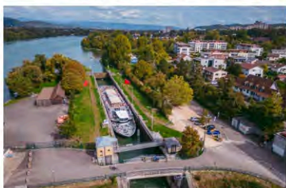
Der «Rhystärn» bei der Schleuse in Augst
