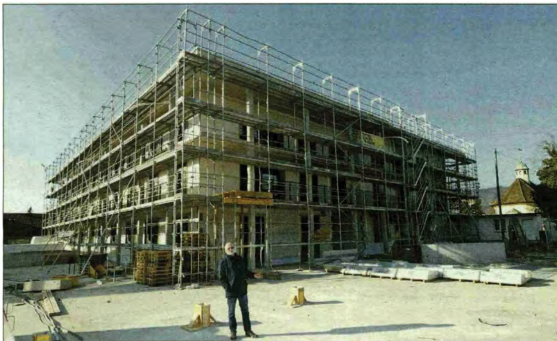
Baukommissionspräsident Werner Gabriel vor dem im Rohbau fertiggestellten «Casa Cura» Fotos: Jörg Wägli
